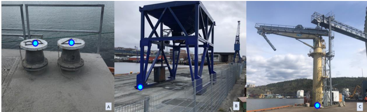
Figur 33: Eksempler på laste- og losseutstyr, med innmålingspunkt. A: lossepunkt manifold, B: hopper, C: lastkran med transportbånd (Oslo havn, Trondheim havn).
