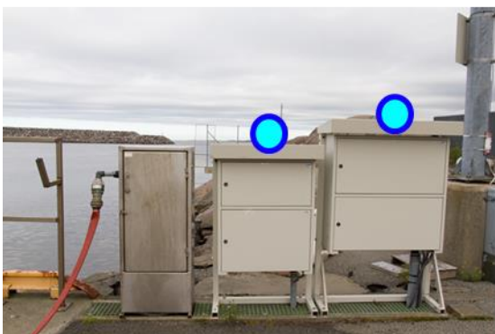
Figur 34: Eksempler på ElKobling med innmålingspunkt. De to øverste bildene er fra Kristiansand havn, det nederste fra Sirevåg. Registreres som enkeltpunkt på objektets midtpunkt i toppen av objektet, tilsvarende som for fordelingskap i FKB. Høydereferanse: Topp. (Norkart, 2020).
