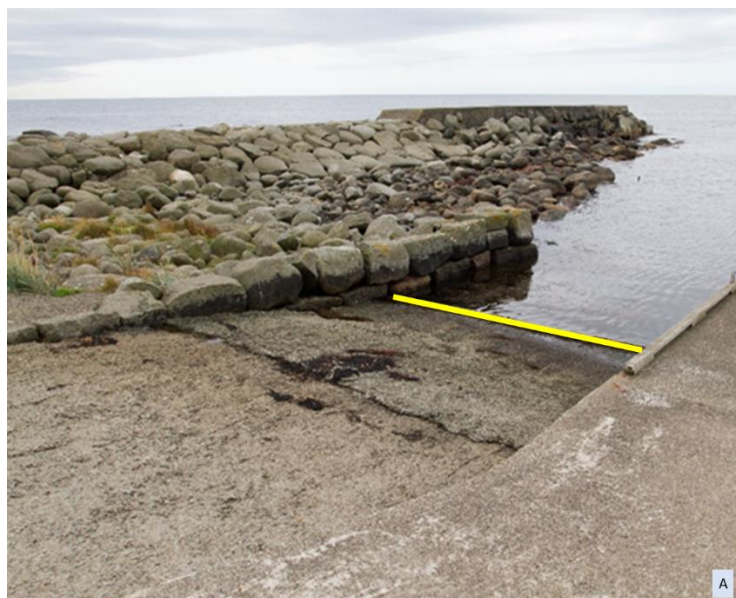
Figur 28: A. Rampe. Registreres som Kaifront – kaifronttype «rampe». Mål inn ved vannkant ved middels høyvann. B. Søylekai.
