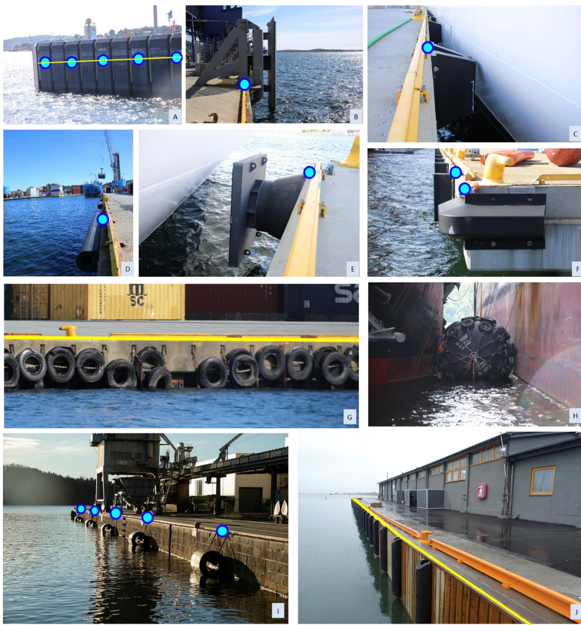
Figur 31: Eksempler på noen ulike fendertyper med innmålingspunkt. Bildene er fra Kristiansand havn og Oslo havn (Foto: Norkart og Oslo havn KF). A. Fenderpanel (Gul linje i dette bildet illustrerer hvor kaifronten går bak fenderne.) B. Torsjonsfender, C. V-fender, D. D-fender, E. Conefender. F. V-fender. Disse kan måles inn med enkeltpunkt eller som grupperte fendere, G. Dekkfending, H. Pneumatisk fender. Denne fendertypen lagres et sted i havnen, og flyttes inn mellom fartøy etter behov. Registreres som punkt på lagringsstedet, dersom havnen har et fast lagringssted for fendertypen. I. Sylindarfendene, J. V-fendene. Innmåling gjøres på baksiden av fenderne ved feste til kaien. Egenskapen spesifikasjon brukes til å spesifisere målene til fenderen. (Foto A – H, Norkart, 2020. Foto H og I: Oslo havn, 2021).
