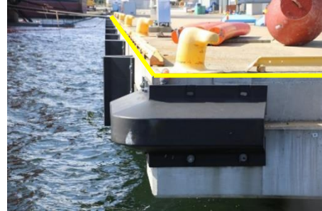
Figur 25: Eksempel på registrering av kaifront (gul linje). Lengden på kaien måles opp langs den delen av kaifronten som egner seg for anløp av skip (lilla linje). Høydereferanse: Topp (Norkart, 2020).
