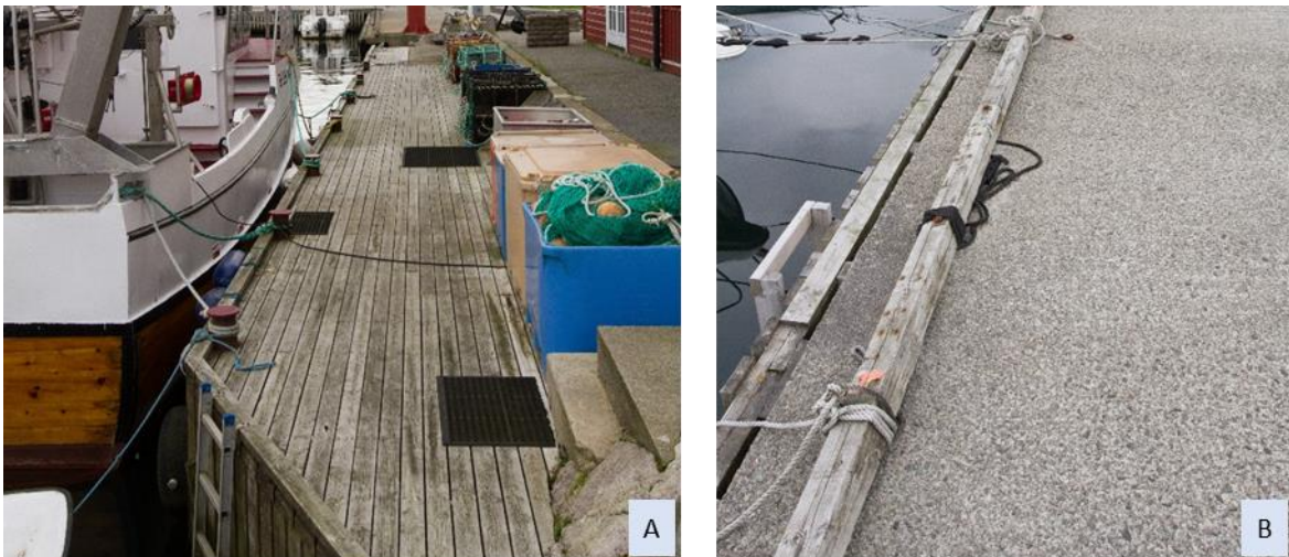
Figur 19: A. Kaidekke i tre, B. Kaidekke i betong.
