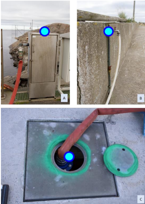
Figur 35: Eksempler på ulike VAUttak, med innmålingspunkt. A. Innmålingspunkt på toppen av skapet. B. På mindre VAUttak settes innmålingspunkt ved vannkranen. C. VAUttak i Kristiansand havn. Her registreres punktet på midten av VAUttaket. Høydereferanse: Topp. (Norkart, 2020).
