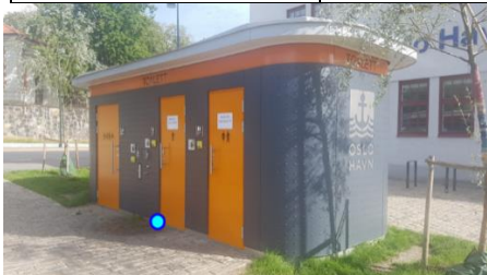
Figur 40: Toalett med innmålingspunkt. Høydereferanse: Fot. (Oslo havn KF, 2020).
