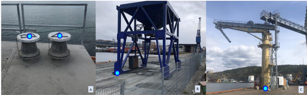
Figur 33: Eksempler på laste- og losseutstyr, med innmålingspunkt. A: lossepunkt manifold, B: hopper, C: lastkran med transportbånd (Oslo havn, Trondheim havn).
