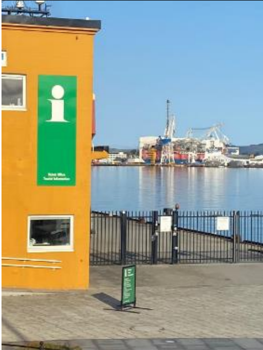
Figur 10: Et ISPS Havneanlegg (ISPS-område) kan avgrenses av f.eks. bygning, havnegjerde og kaifront, slik som vist i eksempelet ovenfor. Det kan registreres med utgangspunkt i geometrien til disse objektene (Foto: Stavanger havn, 2020).
